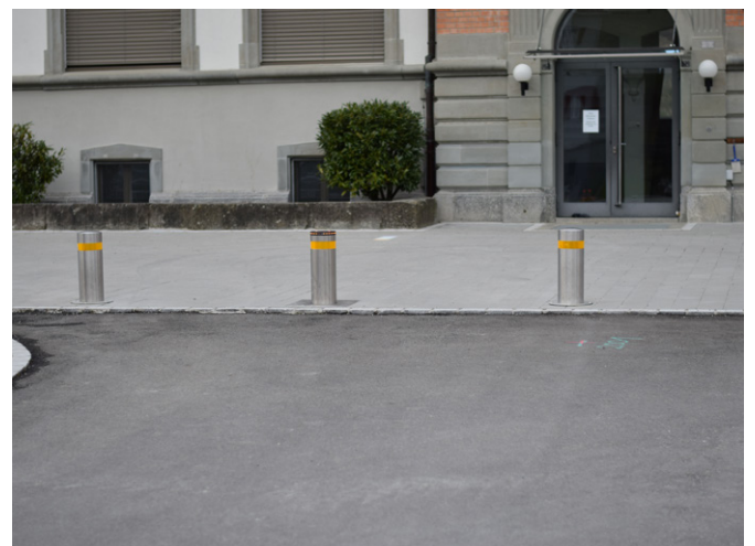
ProTECT "F" Fix und Senkpoller beim Schulhaus Thal
