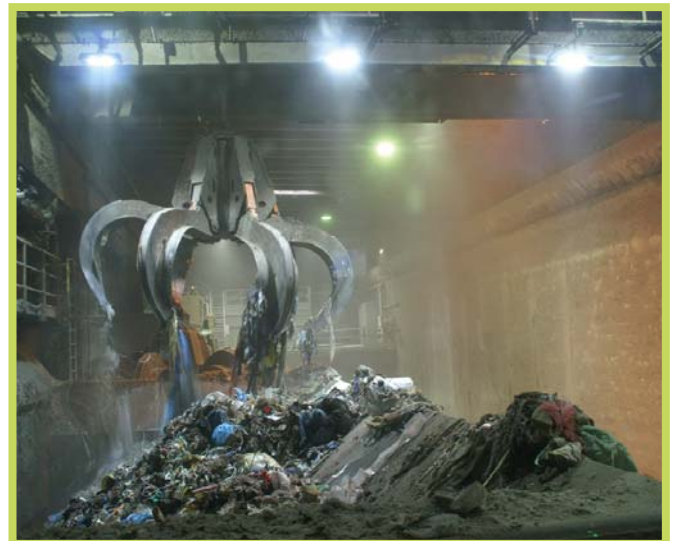
PLAZA - Beleuchtung in Müllverbrennungsanlage
