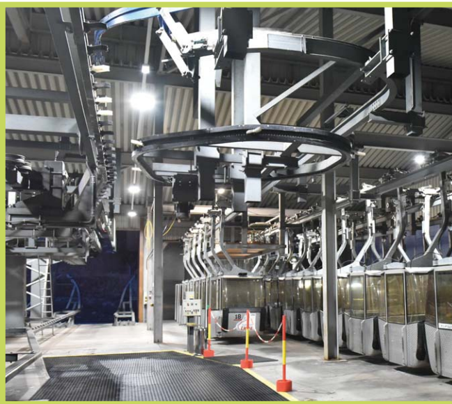
DeltaLUXX - Beleuchtung Gondelstation
