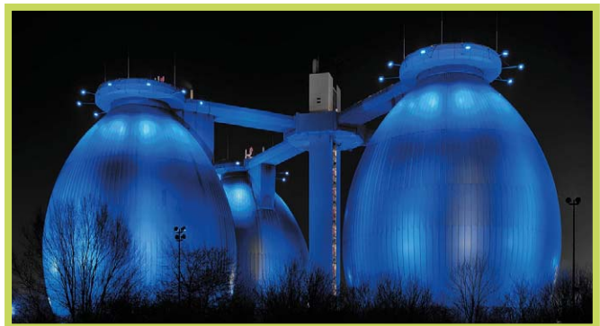
DeltaLUXX Blue - Außenbeleuchtung Klärwerk
