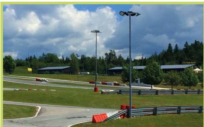
DeltaLUXX - Beleuchtung Fahrsicherheitszentrum
