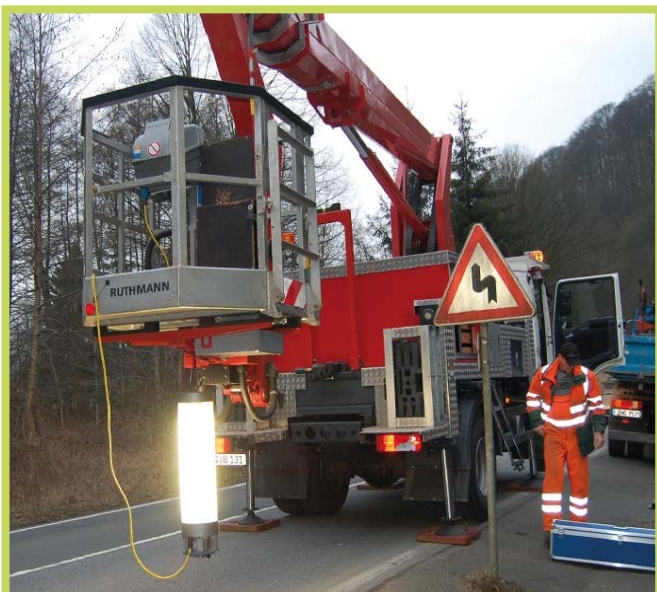
ApolloLED - zur Ausleuchtung bei Straßen- / Waldarbeiten
