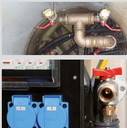
Wasseranschluss im / am Schacht oder Wasseranschluss am Schachtdeckel.
