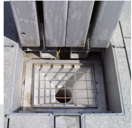
Neuer Platz in Klagenfurt: Abwasserschacht mit Gitter. Während der Abwasserschlauch eingesetzt ist kann der Schacht geschlossen werden.
