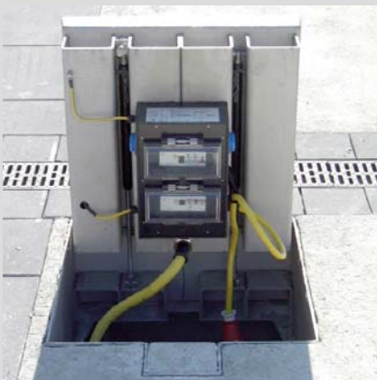
Hauptbahnhof Linz: eingebaut über Tiefgarage (geringere Einbautiefe - anstatt 910 mm nur mehr 510 mm).
