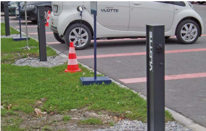
GAS 160 - zur Ladung von Elektro-Autos - Vorrarberger Kraftwerke Bregenz
