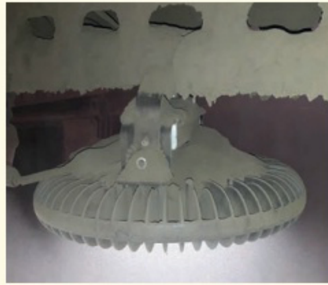
Hallentiefstrahler DeltaLUXX unter hoher Staub- und Schmutzbelastung
