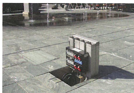
Unterflurverteiler (geschlossen und geöffnet)
