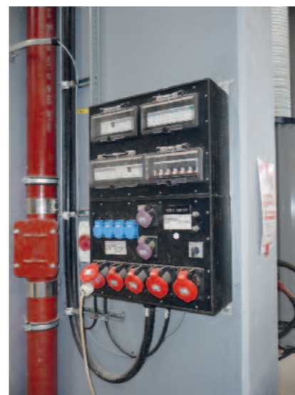
Der absolute Klassiker – Vollgummi-Wandverteiler eingesetzt im Industriebereich.
