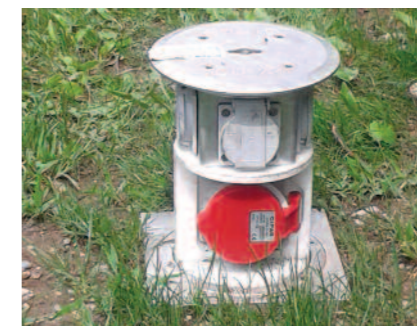
Die Bodensteckdose MASSO aus Aluminium dient als sichere Stromquelle im öffentlichen Park.
