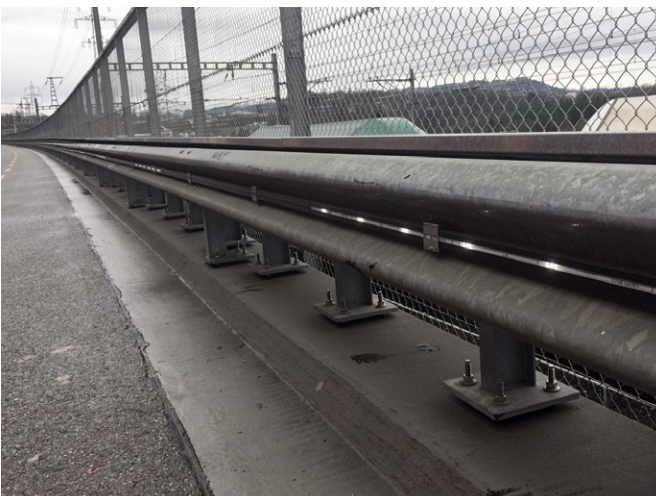
Beleuchtung Radweg Ittigen
