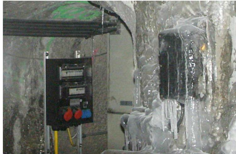
**Tauferschleuse** - auch bei tiefen Temperaturen oder unter Eis, kein Eintritt von Wasser oder Feuchtigkeit
