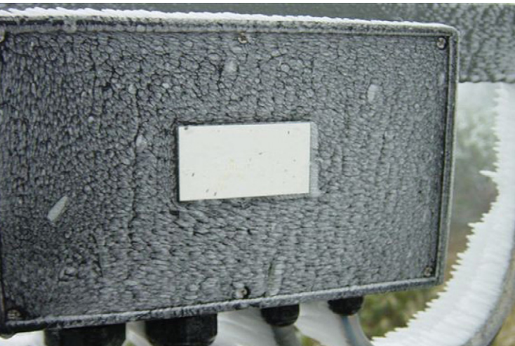
Klemmverteiler - keine Kondenswasserbildung sowie kein Eintritt von Wasser oder Feuchtigkeit im Inneren des Gehäuses
