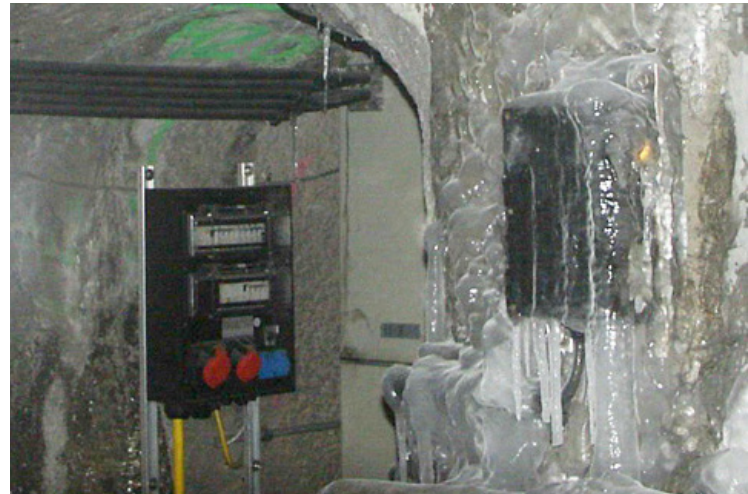
Tauernschleuse - auch bei tiefen Temperaturen oder unter Eis, kein Eintritt von Wasser oder Feuchtigkeit
