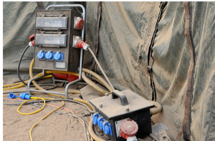
Einsatz Tschad - kein Eintritt von Staub und Sand, volle Funktion auch bei hohen Temperaturen, keine negativen Auswirkungen durch UV Strahlung
