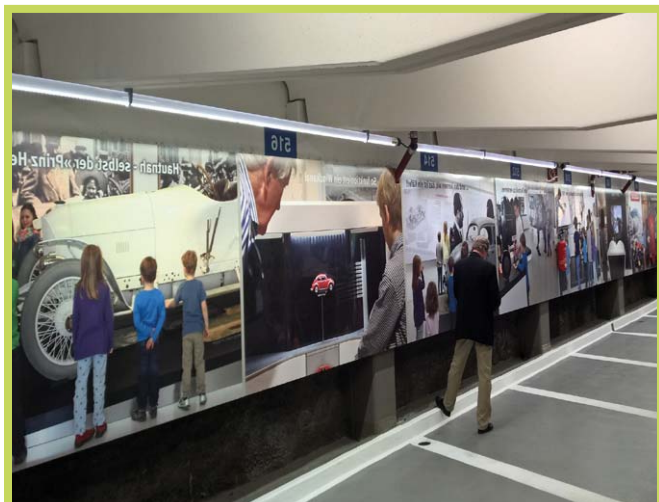
StreamLED Power - Tiefgaragenbeleuchtung
