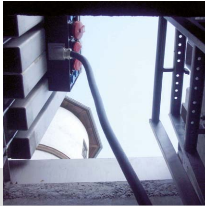
Junkers-Schlössle Götzis: Unterflurverteiler PIAZZA 1000 für Stromversorgung sowie auch als Einstiegsschacht.
