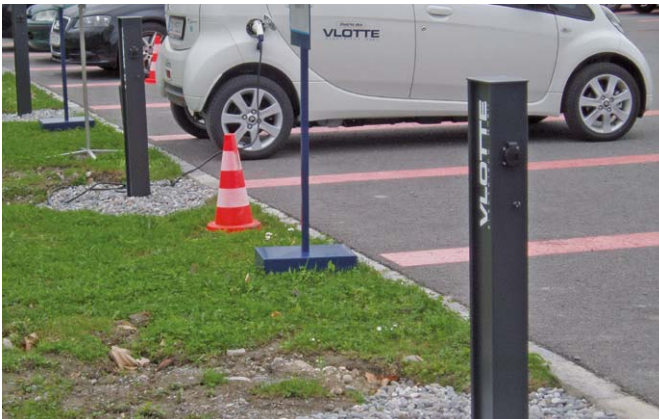
GAS 160 - zur Ladung von Elektro-Autos - Vorarlberger Kraftwerke Bregenz
