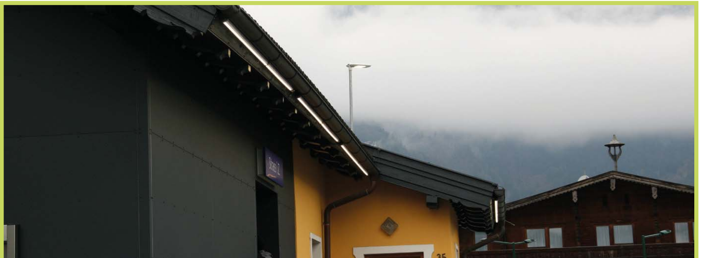
StreamLED Power - Haltestellenbeleuchtung
