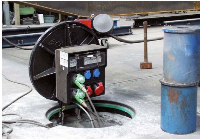
EDV-Nr.: 61347, Künz Kranbau in Hard bei Bregenz
