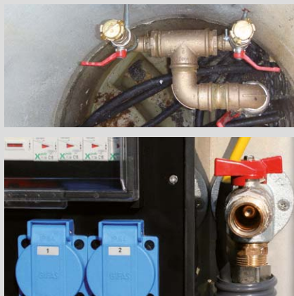
Wassersanschluss im / am Schacht oder Wassersanschluss am Schachtdeckel.
