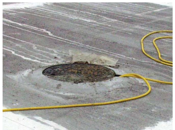
Für einen entsprechenden normgerechten Unterbau, die fachgerechte Montage des Schachtes (Belastung D 400kN) sowie entsprechende Drainage ist bauseits zu sorgen.
