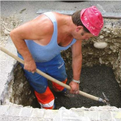
Ausheben der Baugrube aufgrund der erforderlichen Abmessungen. Setzen eines normgerechten Unterbaues sowie einer entsprechenden Drainagierung.
