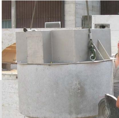
Die auf dem Betonring montierte Edelstahlkonstruktion wird für das Versetzen vorbereitet. Öffnungen für die Zuleitungskabel werden aus dem Betonring herausgeschnitten.
