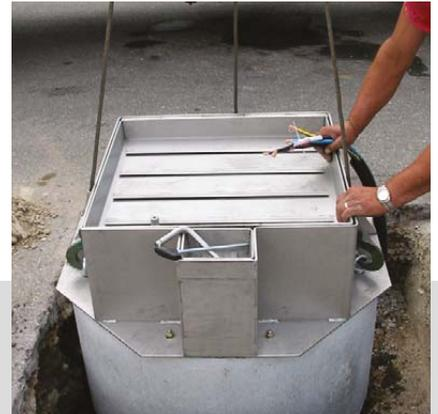
Absenken der gesamten Einheit in die vorbereitete Baugrube mit entsprechenden Hilfsmitteln (Kran).
