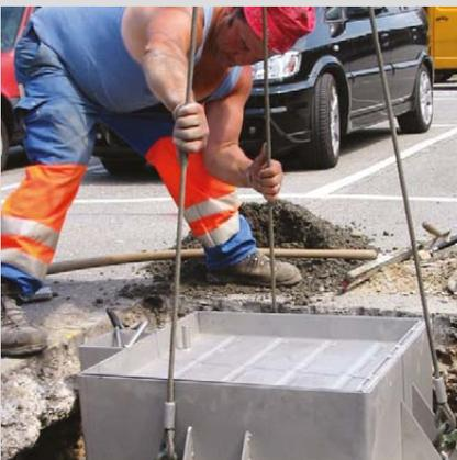
Einpassen der Einheit und Feinnivellierung auf die richtige Einbautiefe (Niveau Belagoberfläche).
