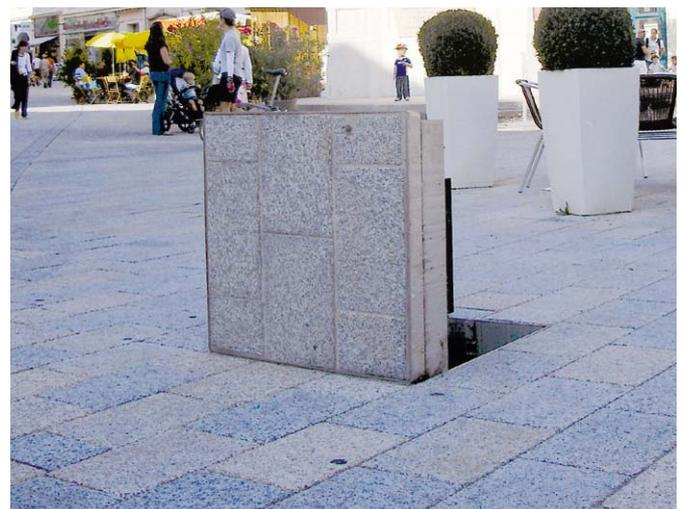
Massive Edelstahlkonstruktion 1000 x 1000 mm, bis D 400kN belastbar, Gasdruckfedern zum leichteren Öffnen, Schachtdeckel individuell befüllbar (Wannentiefe 70mm), Verteiler nach Kundenwunsch.
