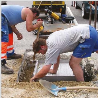
Umfüllung der eingesetzten Einheit und Anfertigung einer Betonmanschette am gesamten Umfang der Edelstahlkonstruktion (siehe technische Zeichnung).
