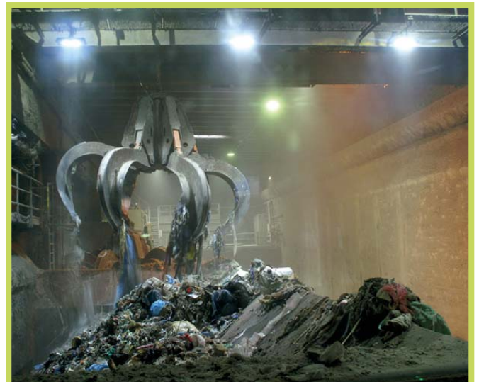
PLAZA - Osvetlenie v spaľovni odpadu
