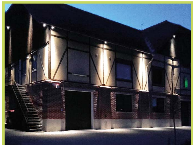
I-LED- Osvetlenie fasády
