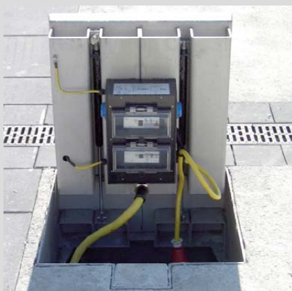
Hlavná stanica Linz: postavená nad podzemnou garážou (malá hĺbka zabudovania - namiesto 910 mm len 510 mm).
