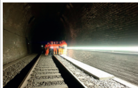
Bild: LED-Handlauf mit hoher Leuchtstärke in der Versuchsstrecke Simplitunnel
