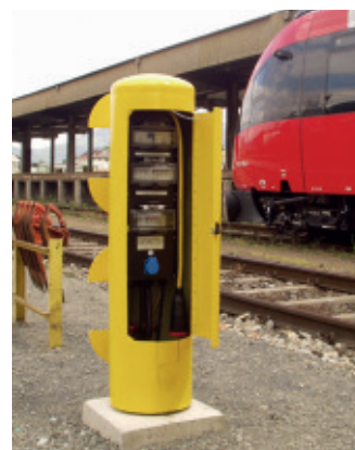
Referenčný projekt: Rakúske železnice (ÖBB), Štajersko / Rakúsko. Stĺpik GIFAS RONDO 300 s káblovým navijakom.
