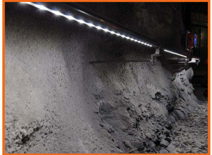
Inštalácia v experimentálnom tuneli Hagerbach
