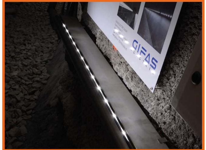
Inštalácia v experimentálnom tuneli Hagerbach
