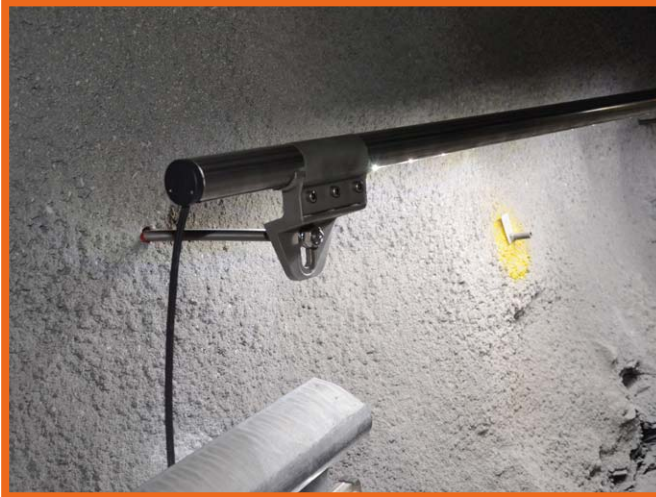
Inštalácia v experimentálnom tuneli Hagerbach
