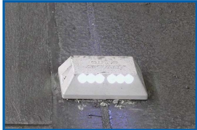
Im Gegensatz zur unterbrechungsfreien Stromübertragung wie beim System MarkLED wird bei der Produktreihe SecuLED das herkömmliche, kabelgebundene System eingesetzt. Die Module können direkt verkabelt und abgeschlauft werden. Vor allem der zweiteilige Aufbau erleichtert den Unterhalts- und Reparaturaufwand massiv.
